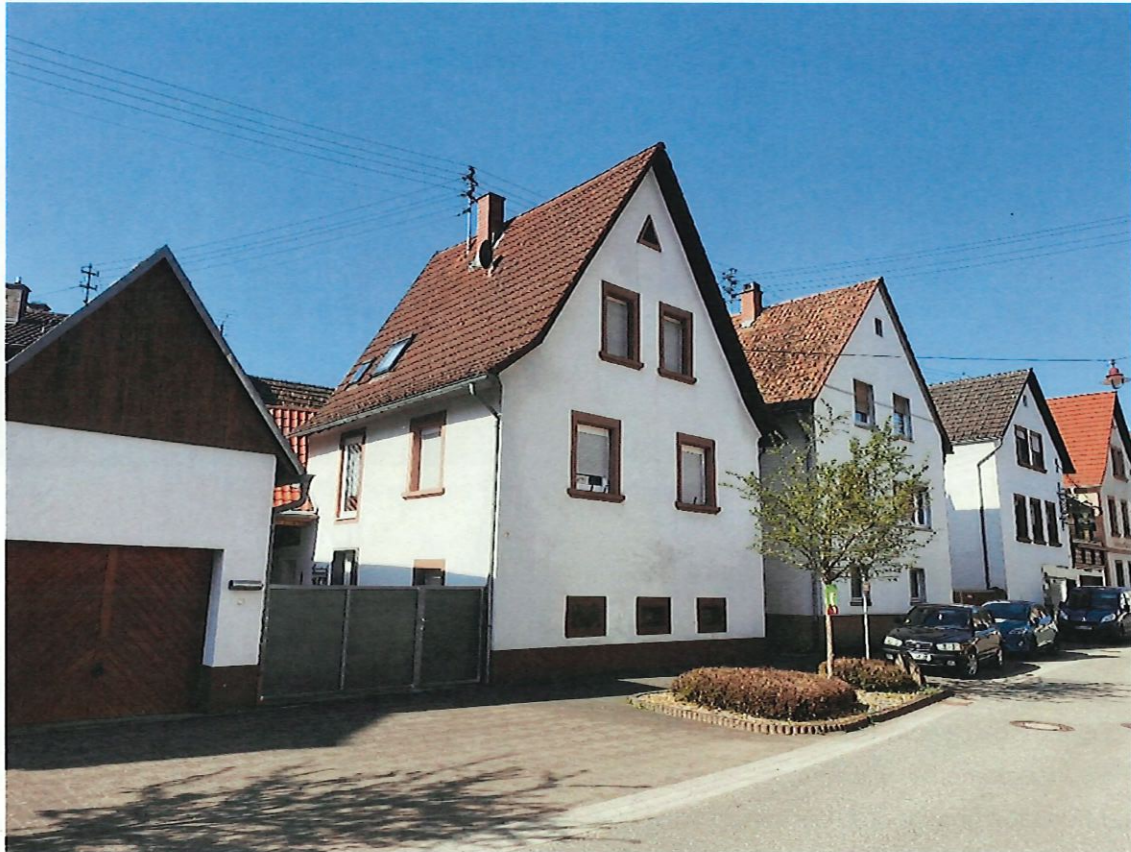
Abbildung 28: Die Pfälzer Haus-Hof-Bauweise in der Hauptstraße (Quelle: Eigenes Foto)
