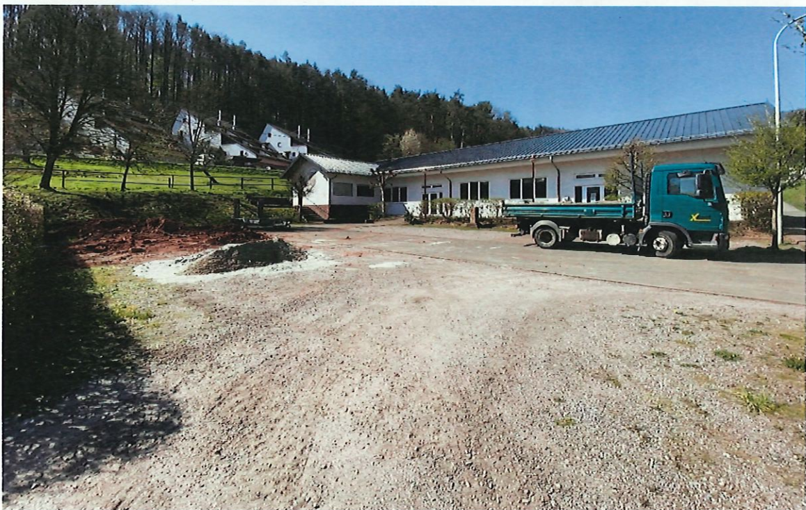
Abbildung 36: Der Außenbereich der Hubertushalle (Quelle: Eigenes Foto)
