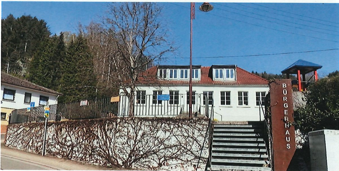
Abbildung 13: Das Bürgerhaus in Schwanheim (Quelle: Eigenes Foto)
