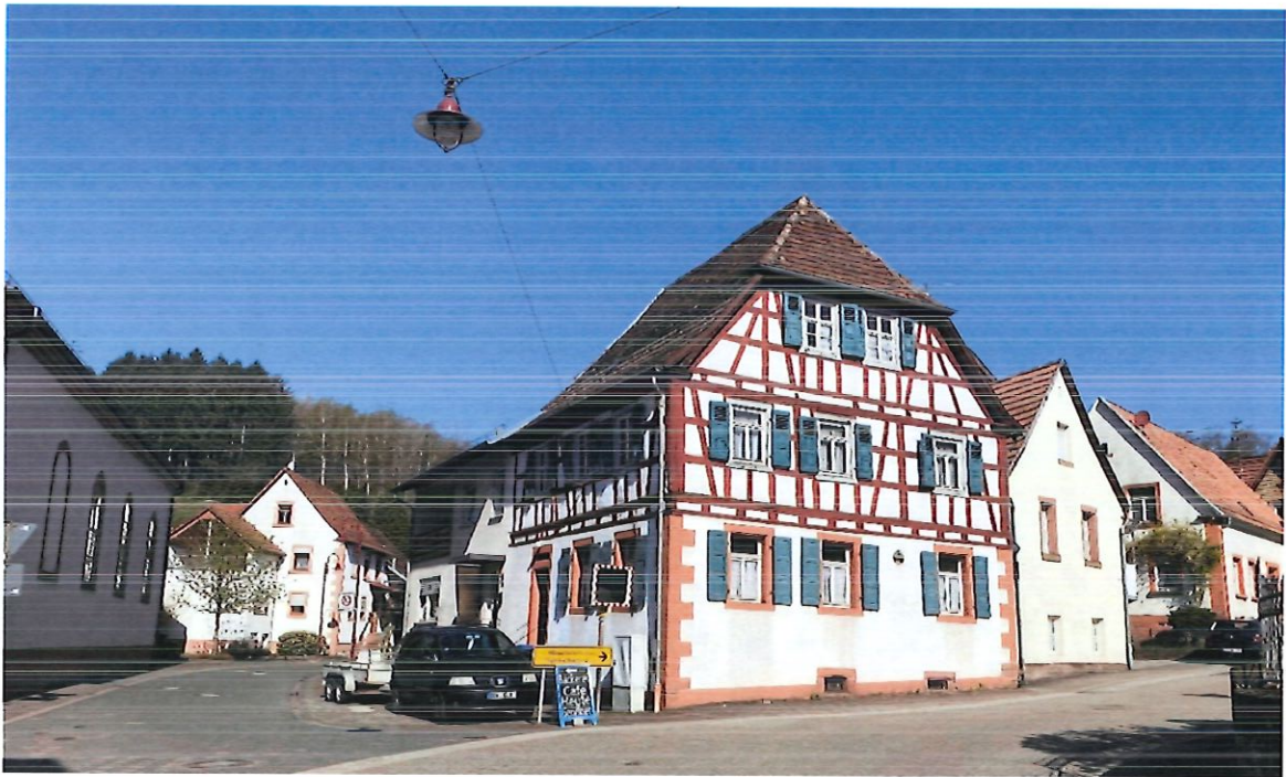
Abbildung 29: Fachwerkhaus mit Krüppelwalm (Quelle: Eigenes Foto)
