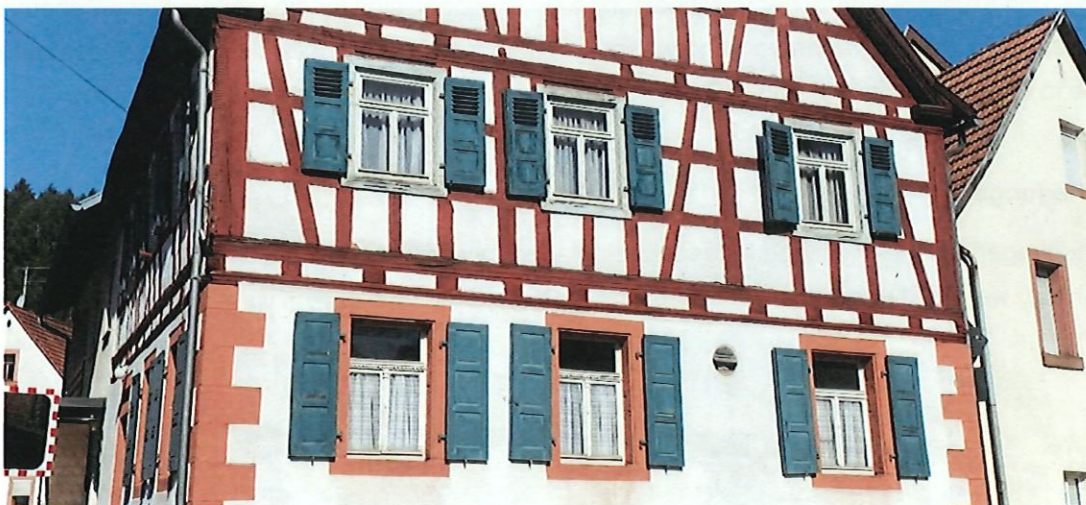
Abbildung 31: Fenster mit T-Sprossen (Quelle: Eigene Aufnahme)
